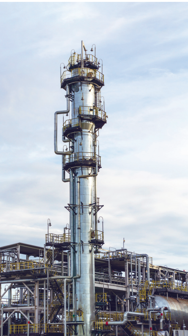
الشكل (19): برج التكسير الحراري.
